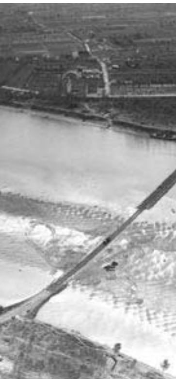
Vista aerea dell'area del ponte e dell'abitato di Bonizzo.
